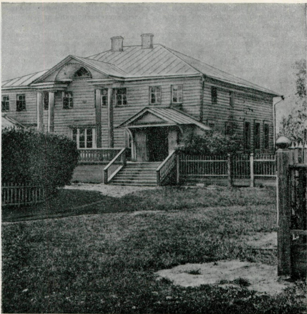
ДОМ ОСТРОВСКОГО В ЩЕЛЫКОВЕ. СЕВЕРНЫЙ ФАСАД
